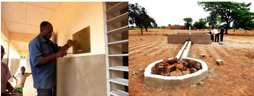
Posa delle targhe a Toungouena Pozzo ed edificio scolastico a Djongolo
