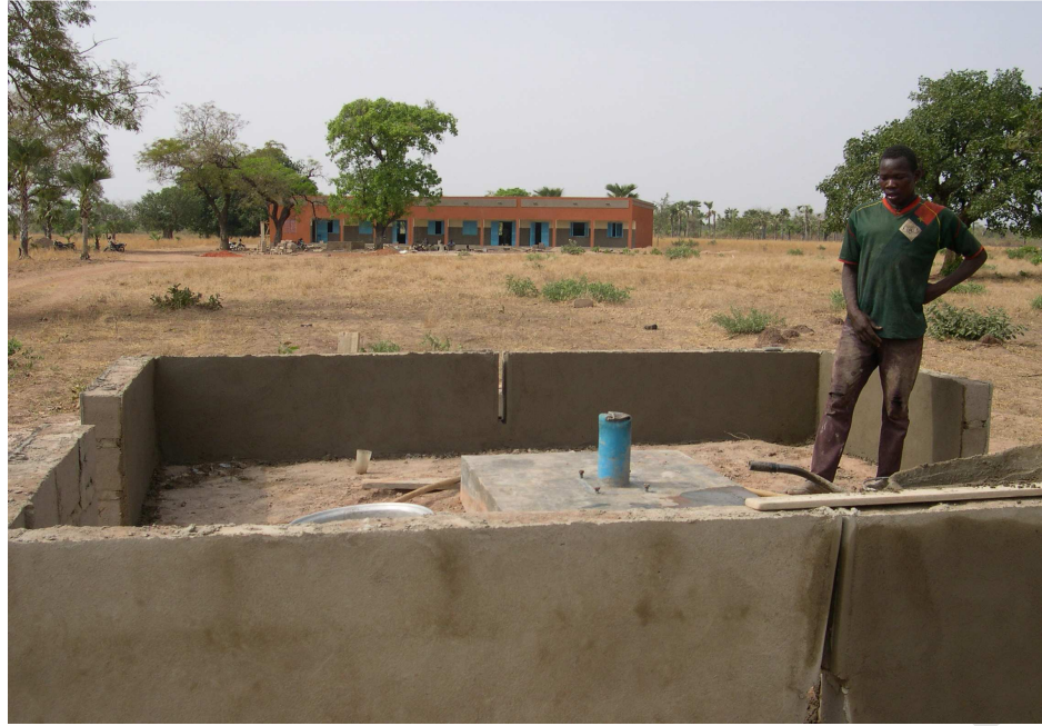
Ecole Diongolo_Vue du forage en construction_1 er mars 2012
